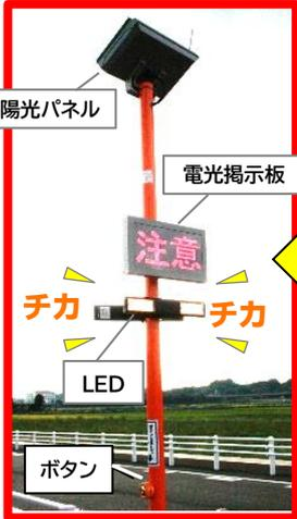
信号機のない横断歩道で、ドライバーに横断者の存在を知らせる装置です。横断者がボタンを押すと「注意」「歩行者」などの文字が表示されるとともにLED灯が点滅します。
